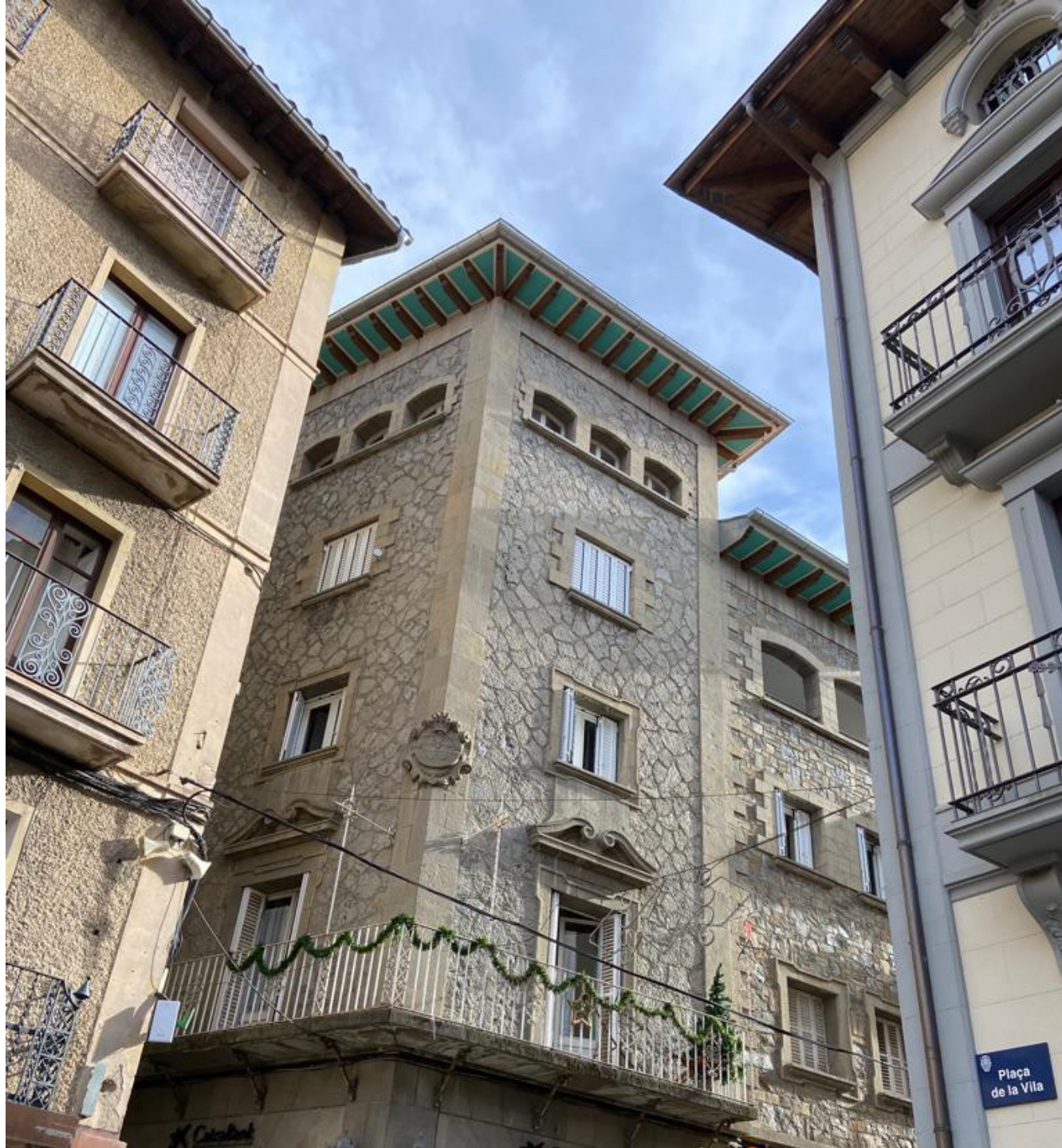
Edifici Caixa de Pensions Raimon Duran i Reynals
